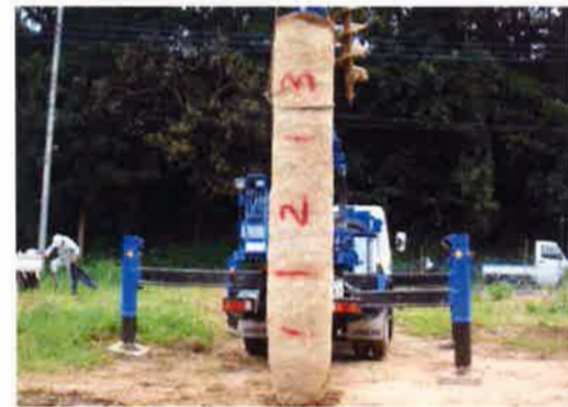
写真-2 SST 工法により築造された柱状改良体
