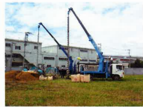
写真-1 SST工法による施工の様子
