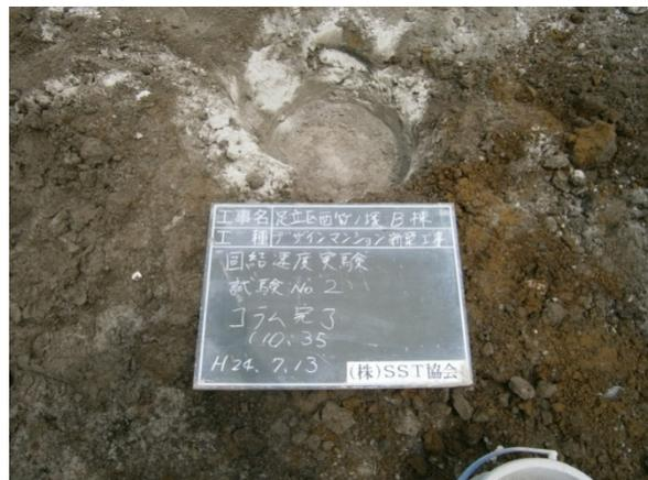
写真-2 SST コラム打設完了
