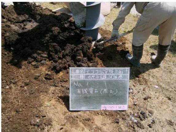
写真-1 掘削中 (腐植土)
